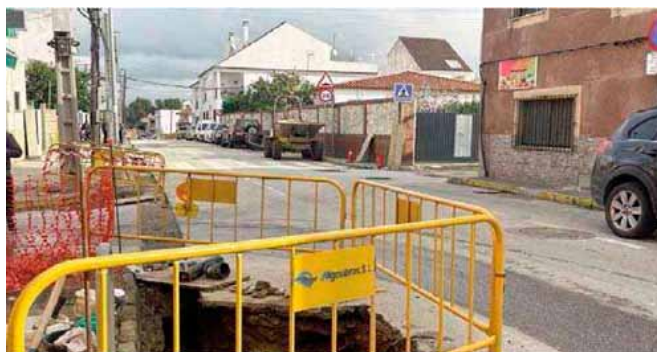
Fotografía de las obras que ha comenzado a realizar la empresa Emalgesa. VCG
