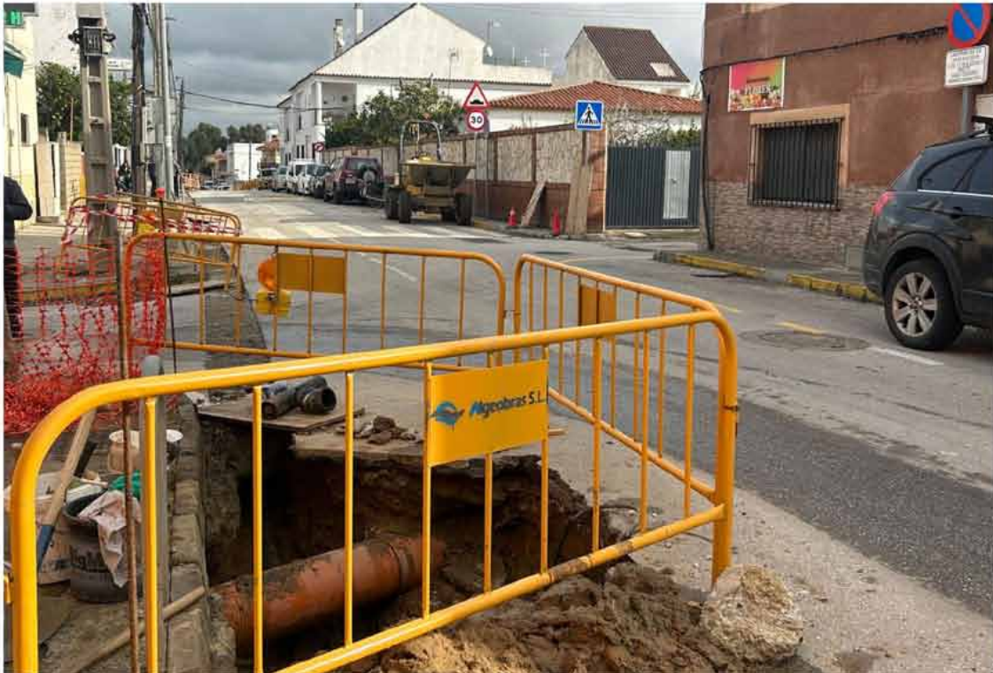
Arranca la segunda fase de las obras en la red de abastecimiento en la avenida del Embarcadero.
