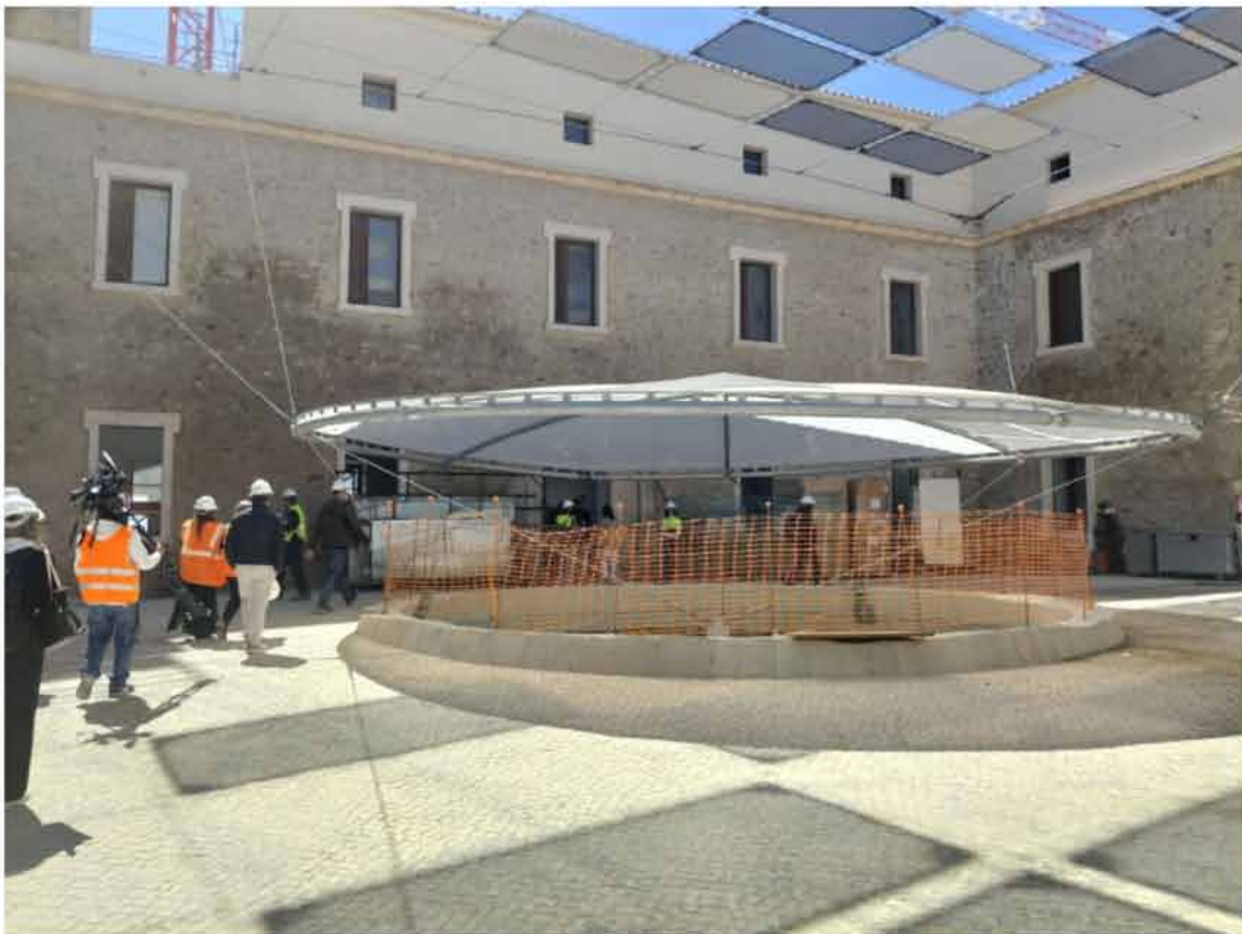
Obras del Parador de Ibiza.
