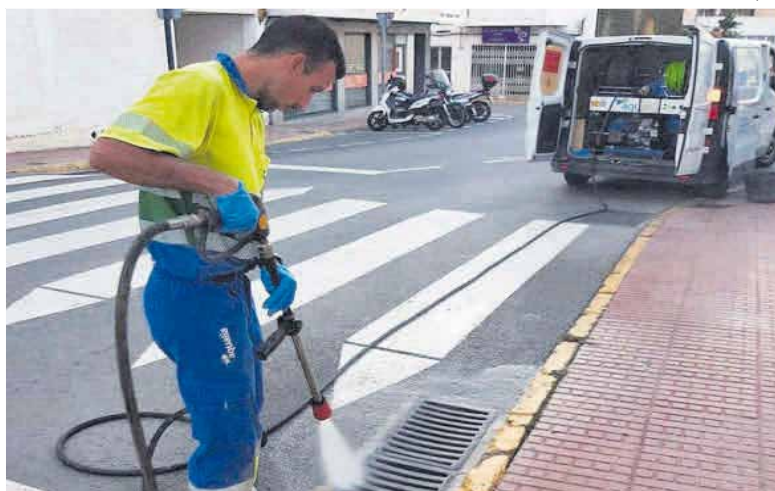
Un trabajador durante la limpieza de imbornales.
